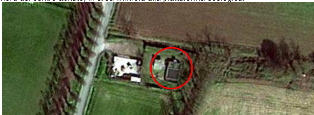
Vista aerea del depuratore comunale
