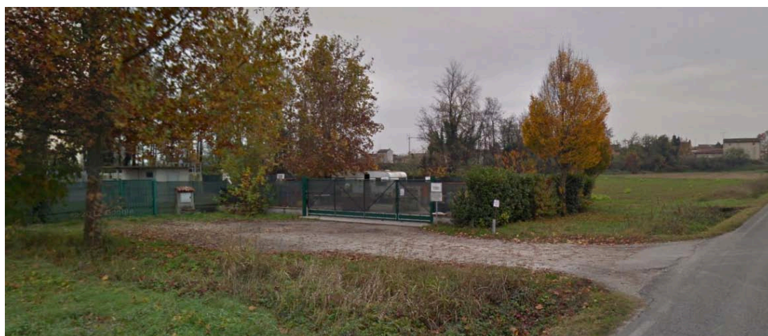
Vista sulla piattaforma ecologica, comune di Scandolara Ripa d'Oglio
